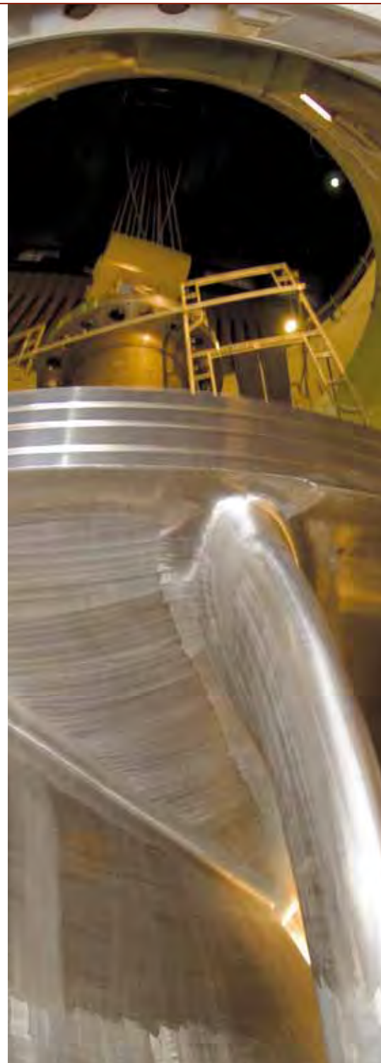
Instalación de nuevo Rodete contemplado en el Proyecto de Rehabilitación de Guri
